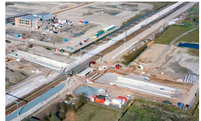
Bouw van de tunnel onder het spoor
